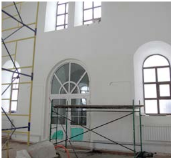
Внутренние работы в храме по состоянию на ноябрь 2017 года
